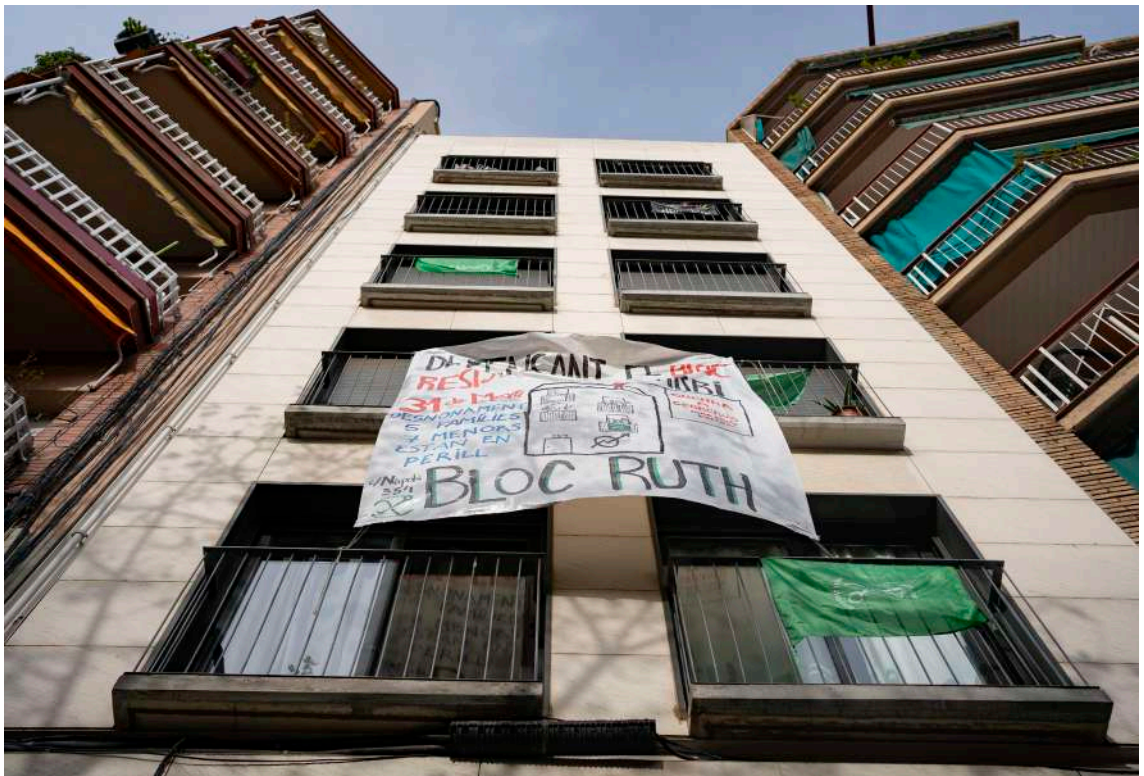
10. La fachada del Bloque Ruth unas horas antes que se suspendiera el primer intento de desahucio.
